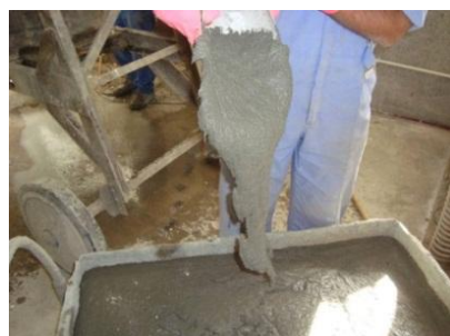
شکل ۱. مخلوط بتن فوق توانمند الیافی
